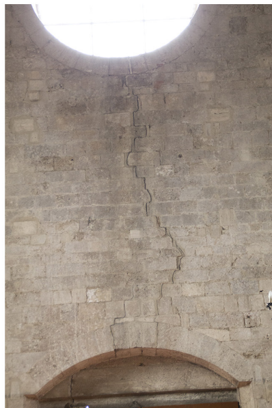
36 Foto fessurazione facciata e controfacciata
