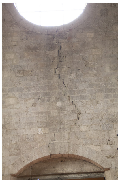
36 Foto fessurazione facciata e controfacciata
